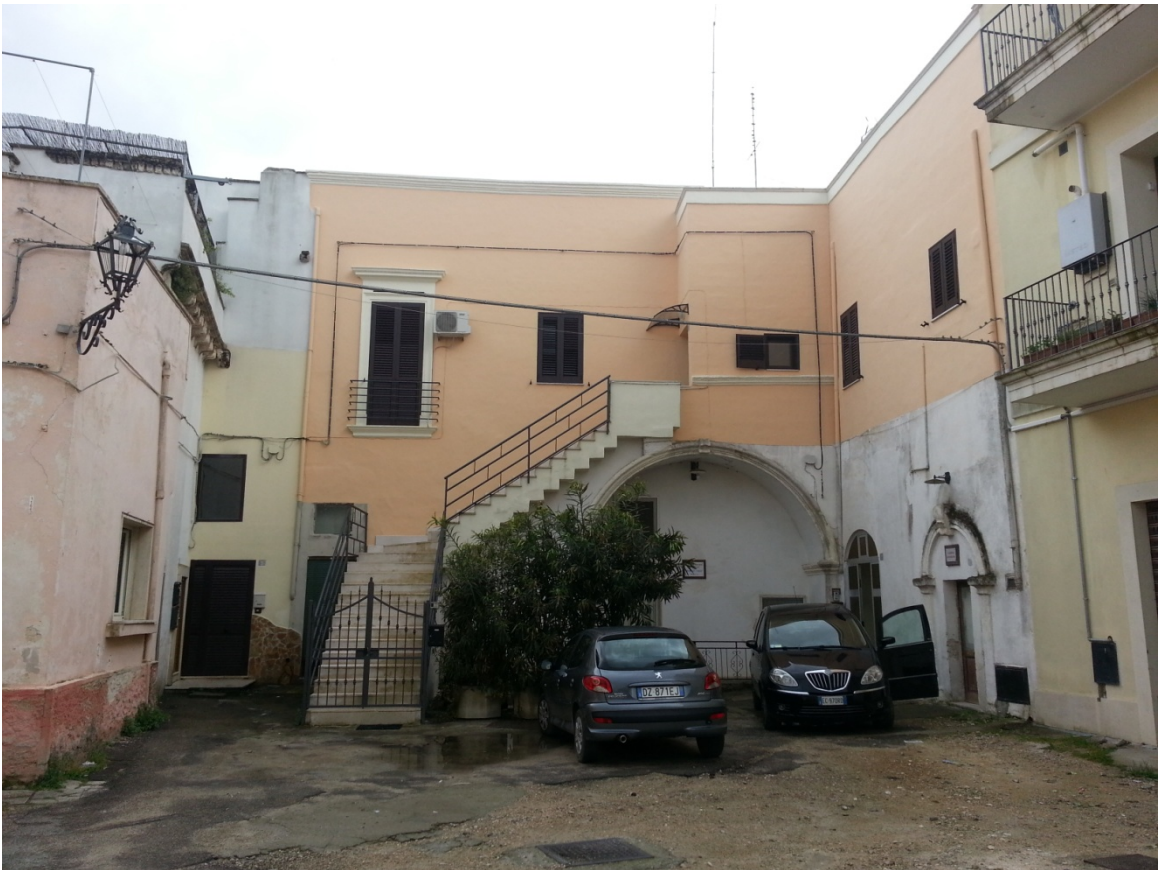
Piazzetta adiacente Piazza S. Antonio, risultato della demolizione di un fabbricato del tessuto edilizio minore.
