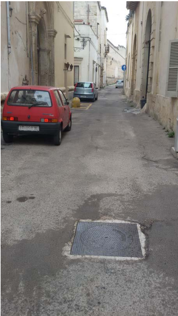
Tratto di via San Giovanni interessato dall'intervento.
